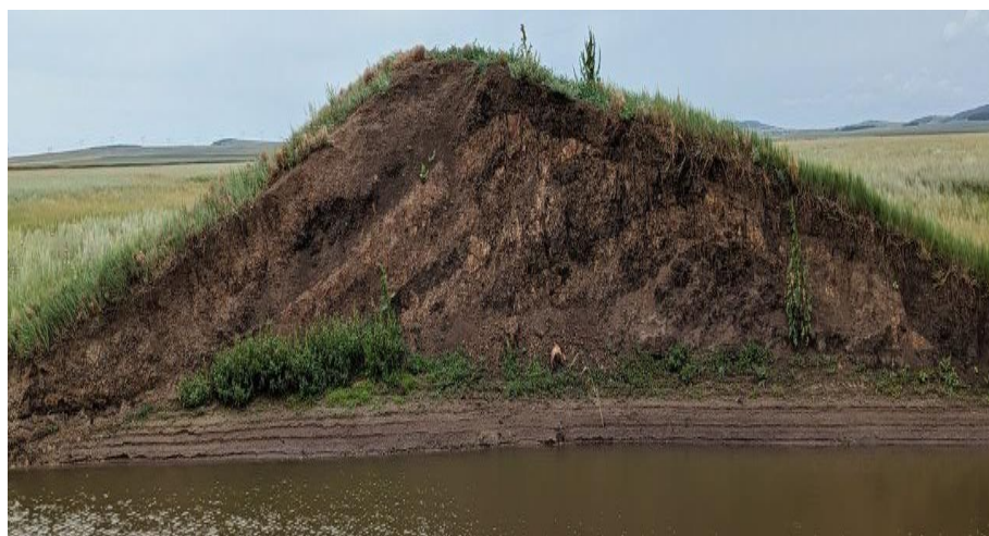
Рисунок 7 - Проемы в плотине
